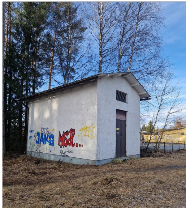
Kuva 6 Kuva suunnittelualueen pohjoisosan puistomuuntamosta. (kuva: Tia Koponen 2.4.2025)
